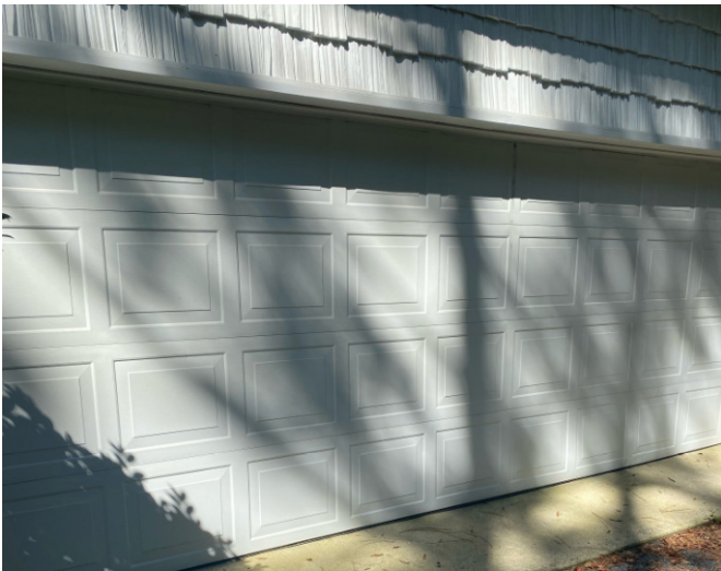
Existing Garage Door
